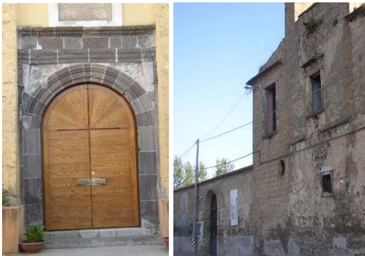
Figura 22. Santa Maria Assunta di Trentola, portale e prospetto del convento del 1500.
