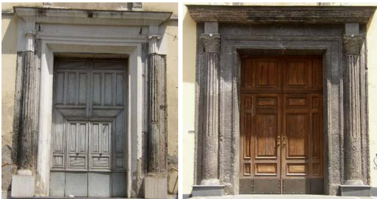
Figura 24. Portali rinascimentali “anticlassici” di San Simeone (a sinistra), San Giuliano (a destra).
